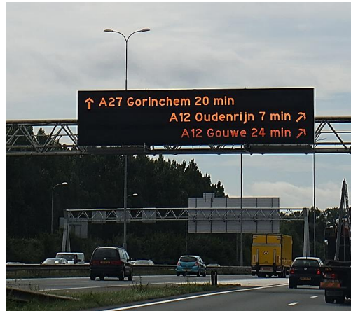
Informereren: Dynamische Route Informatiepaneel
