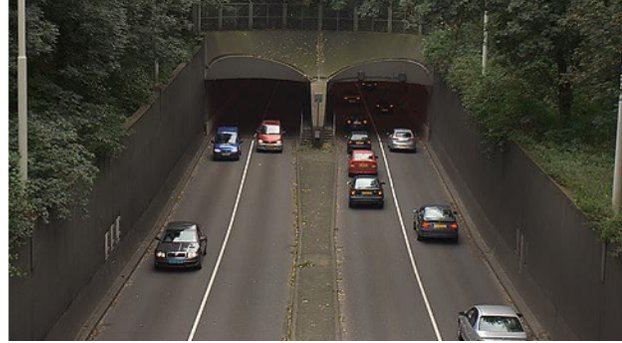
Maastunnel – Rotterdam (Zuid-Holland)
